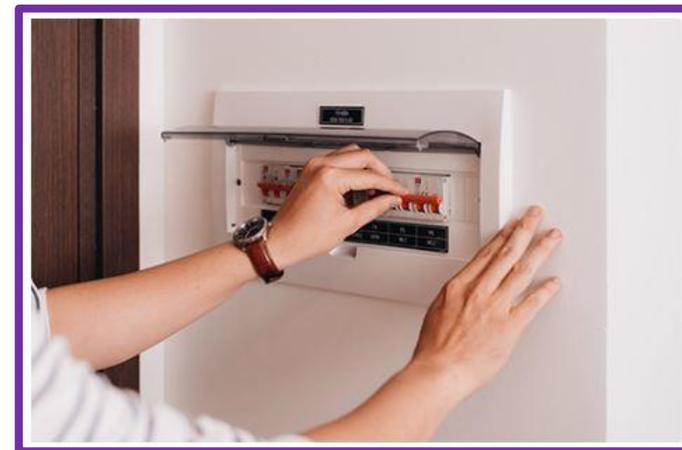
Couper l'alimentation électrique de la machine au tableau électrique
